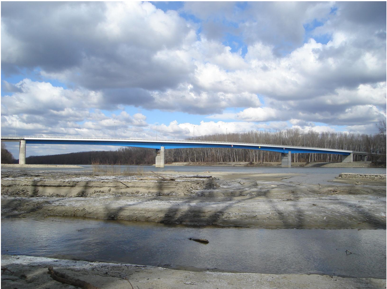
Novi most, zapadna obilaznica grada Osijeka, izgrađen 2007. godine
